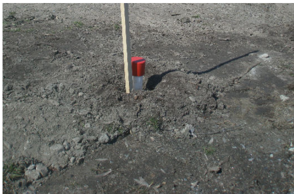
Fig. 8. Ovan visas exempel på anlagt grundvatten rör med lock.
